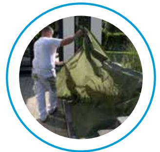
Angrenzende Pflanzen werden immer abgedeckt.
